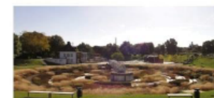
Bottrop: Kläranlage Bernemündung mit versunkenem Garten
